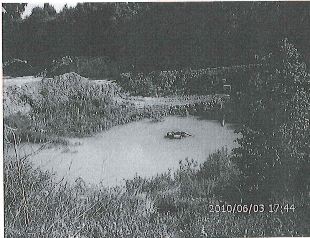
Photographie n°2 : vue du bassin en fond de carrière recevant les eaux des sables
